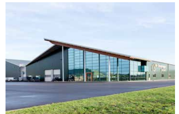
Van Ossenbruggen Fruit vervult een satellietfunctie in de regio geeft JCVANKESSEL Bouw aan
