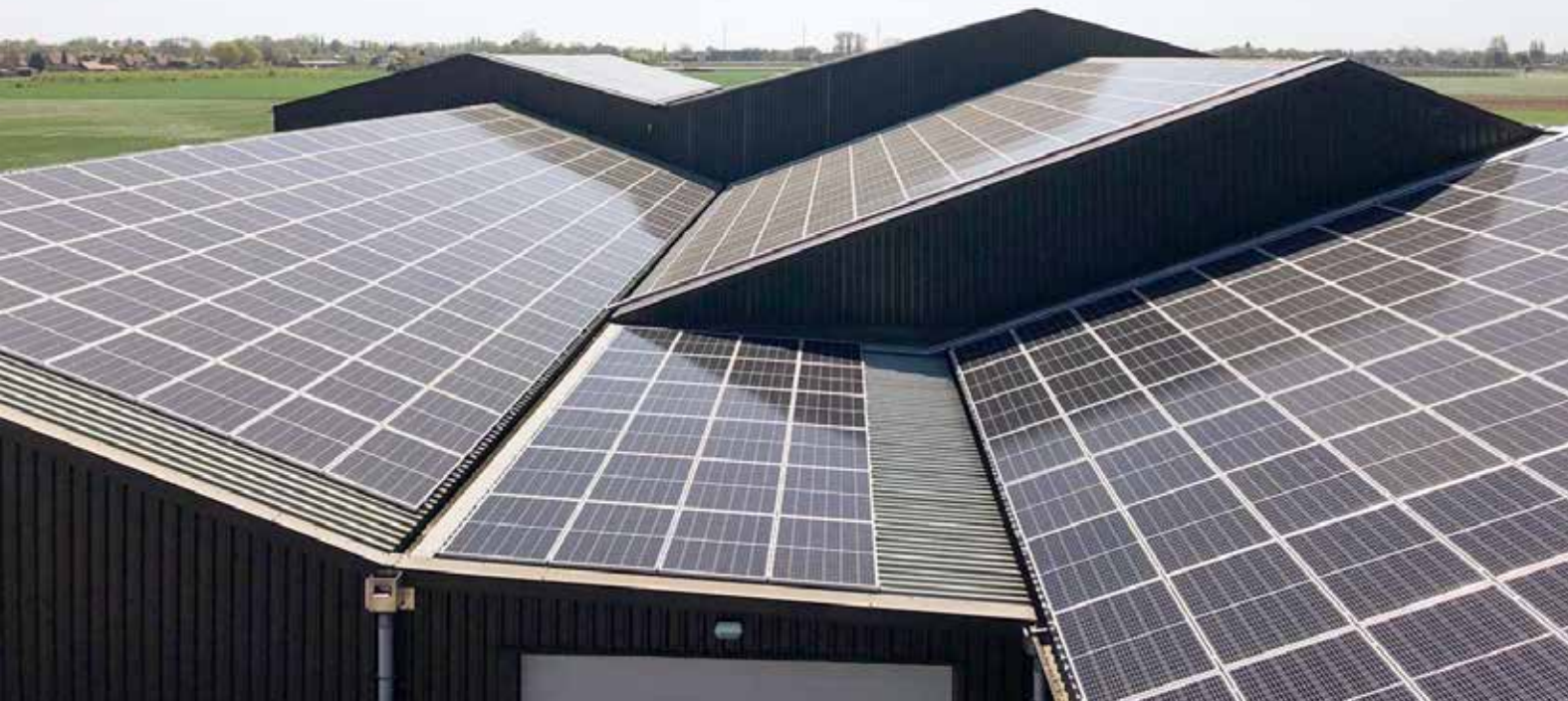
Vaal wordt het dakoppervlak van fruitloodsen gebruikt voor zonnepanelen (foto JCVANKESSEL Bouw)
